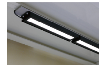
天板裏へ設置
