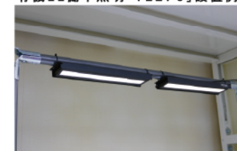
水平なパイプへ設置
