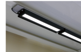
天板裏へ設置
