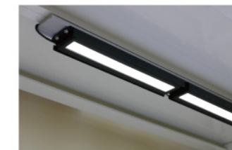
天板裏へ設置
